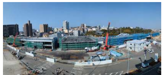
高架化工事中のJR半田駅前
